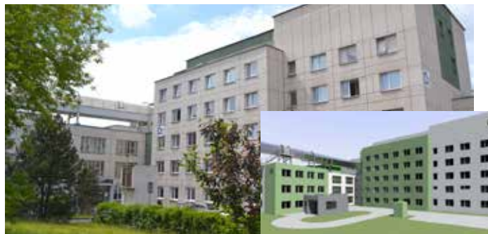
Opláštění objektu D v Masarykově nemocnici v Ústí nad Labem prochází revitalizací, včetně přístavby podlaží.
